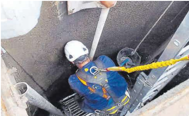
Operarios de la UTE Gestión Cangas, reparando el bombeo de Massó.
