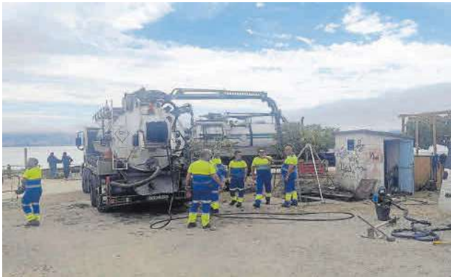
Trabajadores de la concesionaria del agua, la semana pasada, en el bombeo de Massó.
